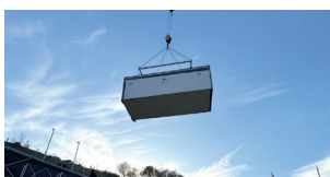
Montage der Holzraummodule auf der Baustelle
